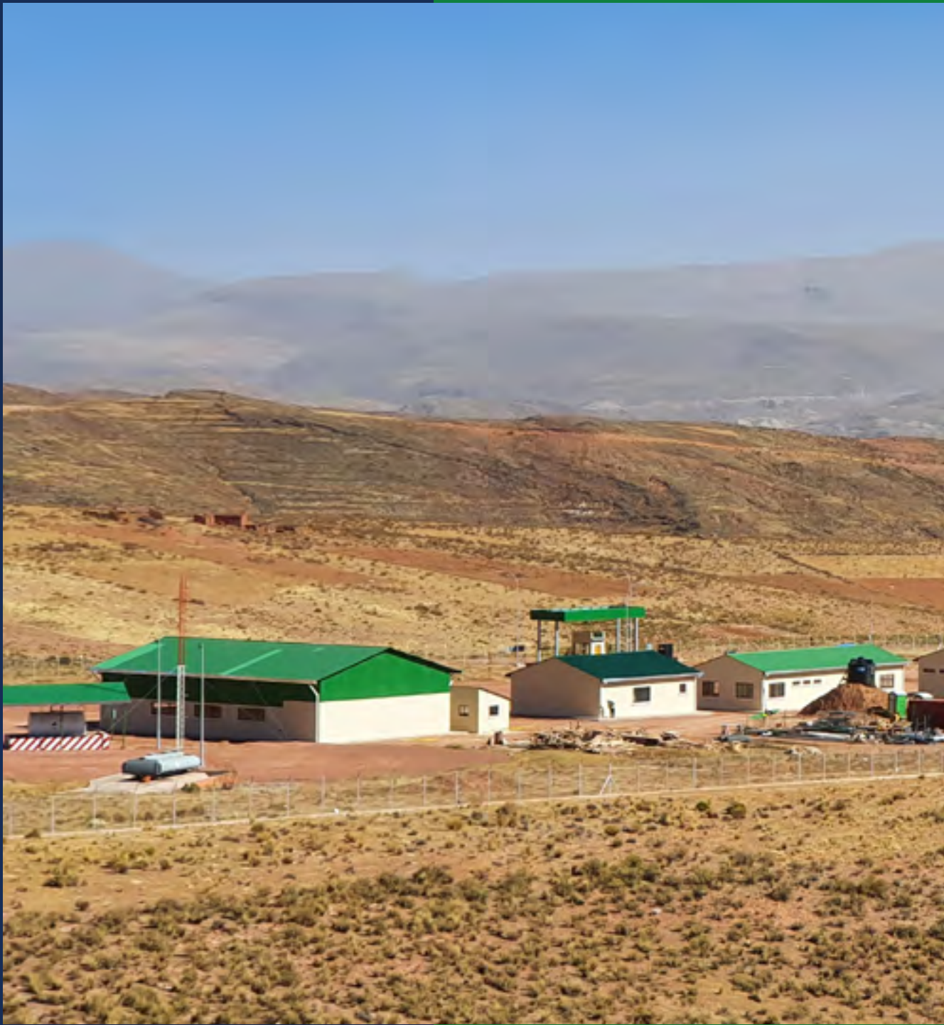
Complejo de Tratamiento de Residuos Sólidos Urbanos para la Ciudad de Potosí, Programa PGIRS BO-L1073. Ministerio de Medio Ambiente y Agua.
