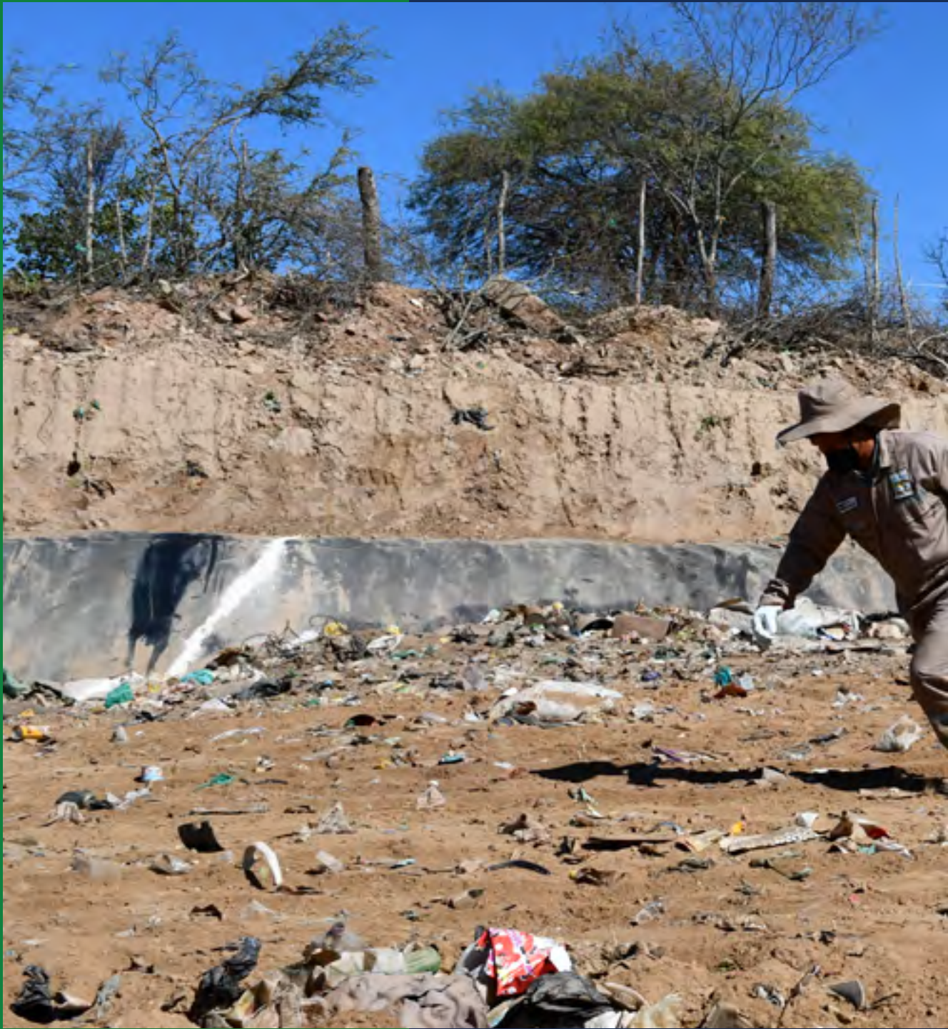
Compactación de residuos solidos en celda de residuos comunes, Relleno Sanitario de Boyuibe. Proyecto Basura Cero en Bolivia
