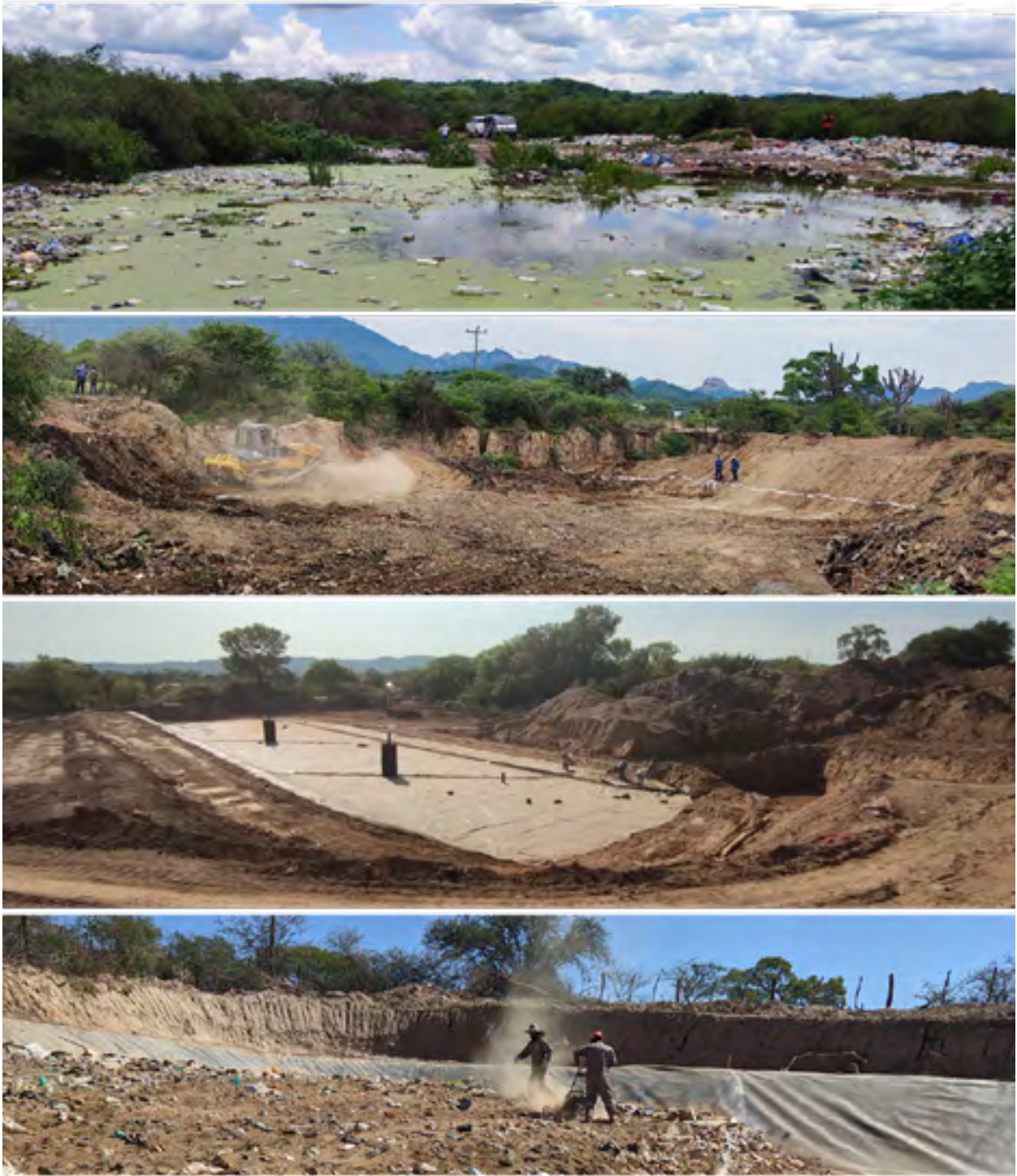
Proceso de Cierre y Rehabilitación de botaderos del Chaco. Basura Cero en Bolivia.
